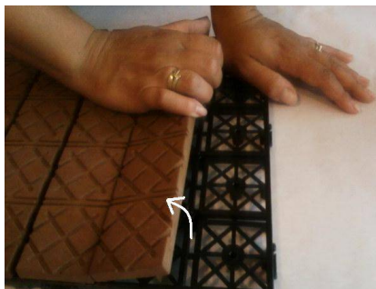
Apoye firmemente la rejilla base y levante la tabla por uno de sus laterales
